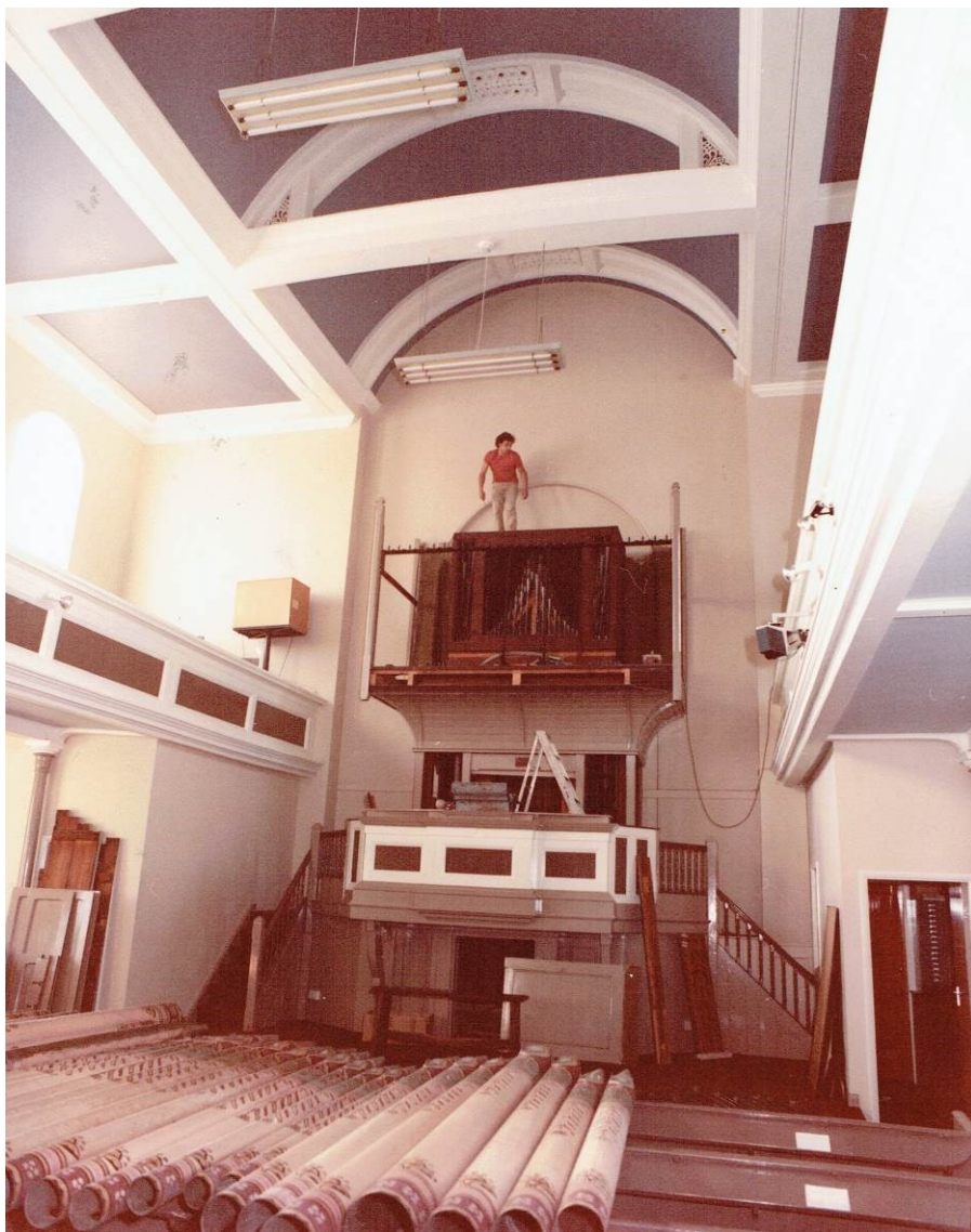
Afb. 7. Opname tijdens de demontage. Allerlei panelen zijn al verwijderd, op de voorgrond liggen al de uitgenomen frontpijpen. De jaloezieën van het Swell zijn al verwijderd, het pijpwerk daarvan is nog niet uitgenomen.
